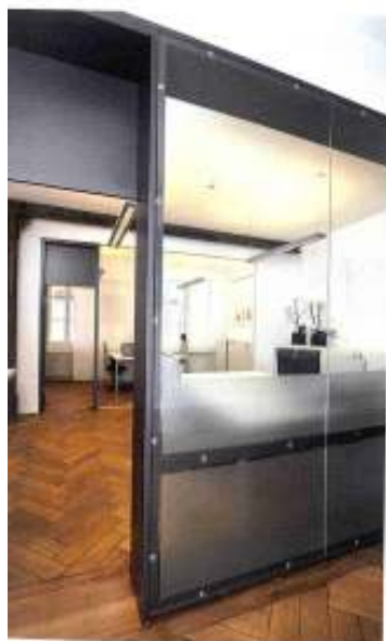
Klassische Volkuss-Stützen und sorgfältig restaurierte Parkettböden in Kombination mit neuen Glas-Trennwänden
