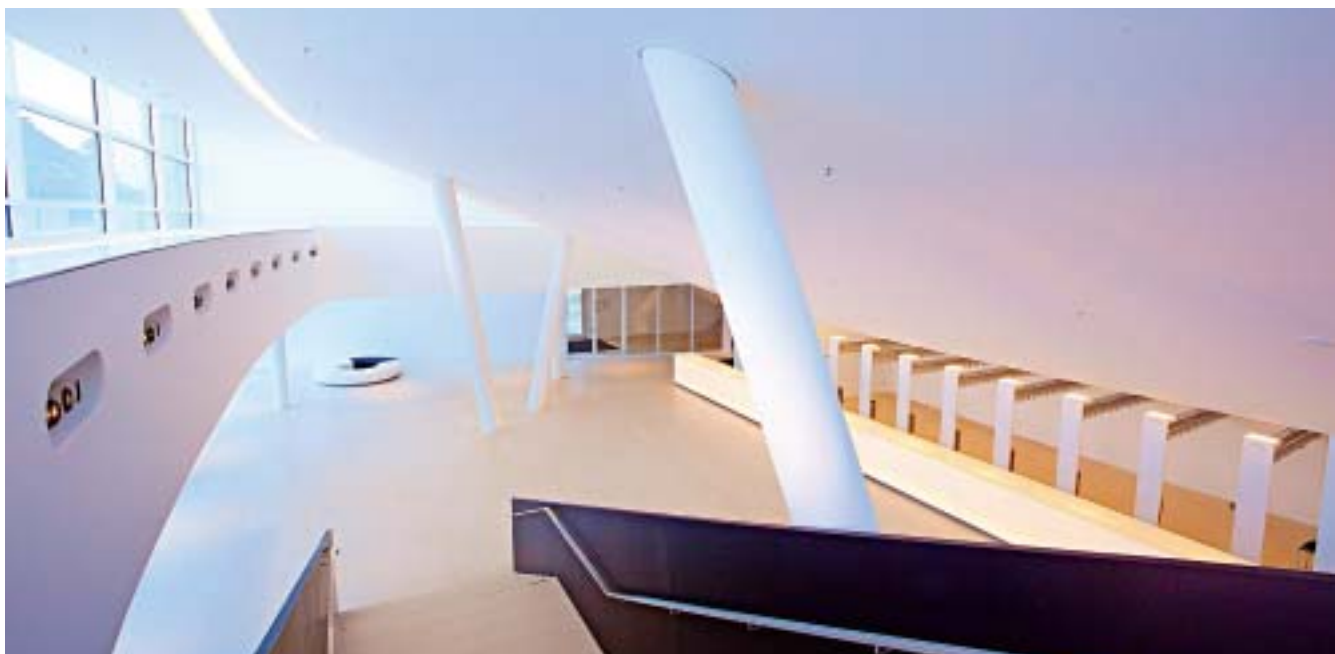
Große ungestörte Flächen und spezielle Lichtsituationen, wie hier das Streiflicht von den Fenstern und den Leuchten, verlangen höherwertige Oberflächenbehandlungen, damit sich die Fugen nicht abzeichnen.
