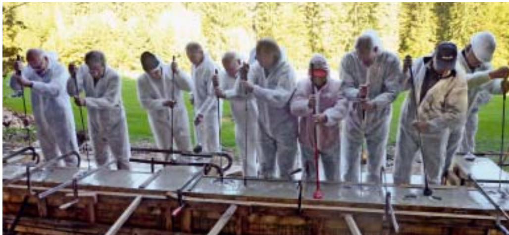
Ohne Fließmittel oder Verfestiger wurde der natürliche Beton vor Ort mit relativ grober Gesteinskörnung gemischt.
