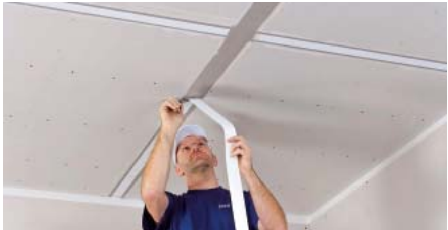
Auf größeren Deckenflächen lassen sich Querfugen meist nicht vermeiden. Platten mit vier statt nur zwei abgeflachten Kanten können dann die Ansichtqualität der Fugen in beide Richtungen verbessern.
