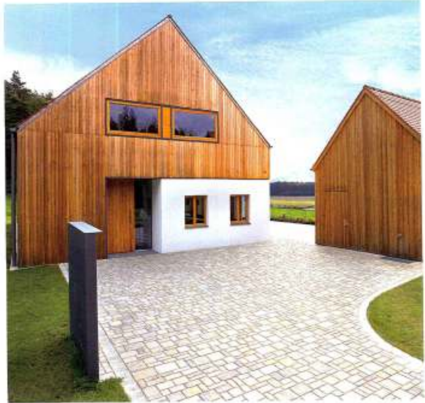
Zeichen: Zum Vorplatz hin bildet der Hauseingang den einzigen Einschnitt in der Fassade
